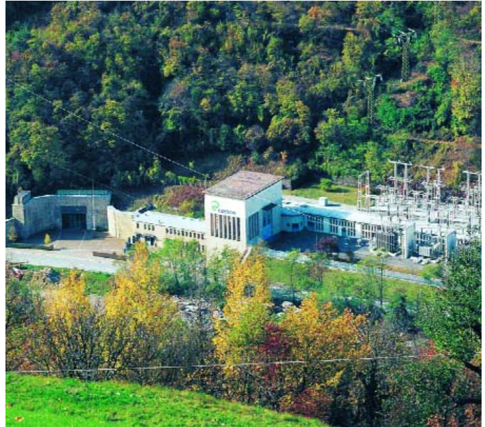
Das Krafthaus - in der Architektursprache der neuen Sachlichkeit gebaut - stammt aus den späten 1930er-Jahren. Die Pläne dazu lieferte Duilio Torres.
