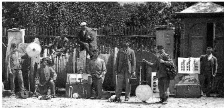
*Der Strom wird nach Meran gebracht. Mit Standesbewußtsein posieren die Arbeiter zwischen Kabelrollen, Lampen, Verbindungsgarnituren und Schalttafeln neben einem Umspannhäuschen.*
