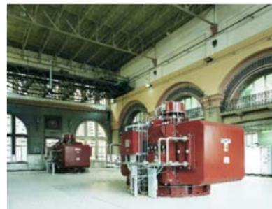
ten Teil als Stahlrohr ausgeführt ist. Über die Druckrohrleitung stürzt das Triebwasser in das Krafthaus, wo es zwei Francis-Turbinen mit je einer Leistung von 8,5 MW antreibt.
