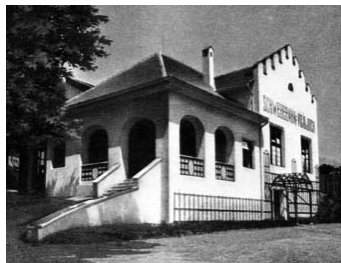
In der Talstation sind die Bahnhofsräumlichkeiten mit Warteraum, Kasse und Buffet, der Bahnsteig sowie die technischen Funktionsräume für die Seilspannvorrichtungen untergebracht.
