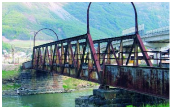
Die Etsch querende Eisenfachwerkbrücke, die 1913 von der Brückenbau-Anstalt Ing. Grindl aus Wien geliefert wurde, hatte eine maximale Steigung von 50 Prozent.
