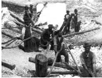
Marmorfuhr auf dem Schleifbaum. Bremsvorrichtung am Berg; historische Ansicht um 1900.
