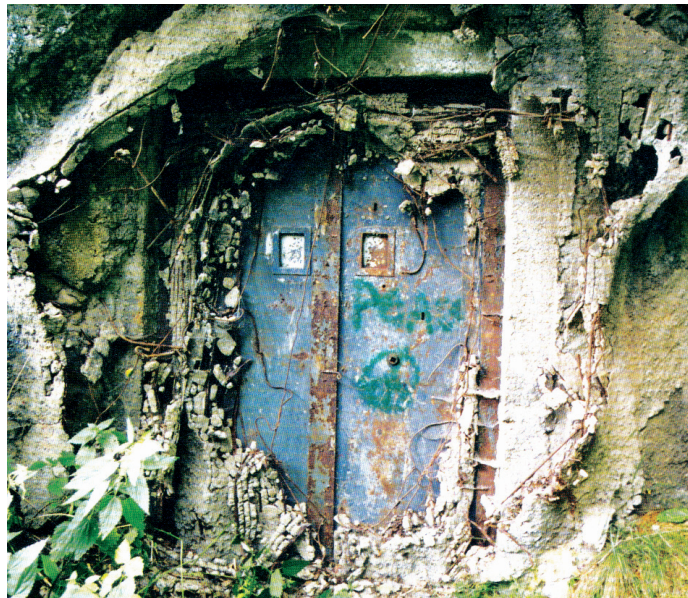
Ingresso principale al Bunker n. 9
