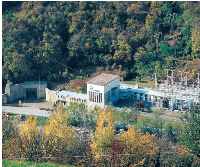
La centrale elettrica edificata in tipico stile neorealista, sviluppatosi dopo gli anni '30; il progetto è di Duilio Torres.
