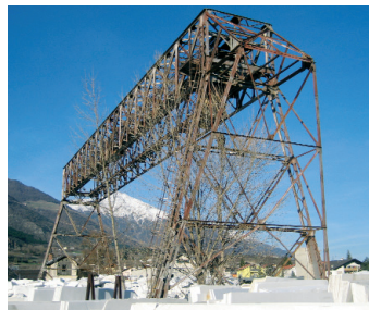
La gru a portale presso la stazione
