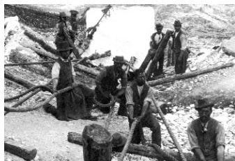
Carico di marmo sulla "lizza" in tronchi Sistema di frenatura a monte; foto d'epoca del 1900 ca.
