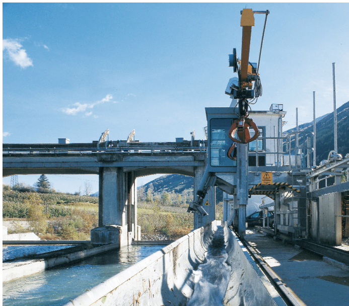
Presa d'acqua e sgrigliatore
