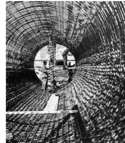
Armatura della galleria in pressione di 12,2 km, 1947. Per la realizzazione dell'impianto idroelettrico sono state necessarie 5 milioni di ore lavorative da parte di 7 mila operai.
