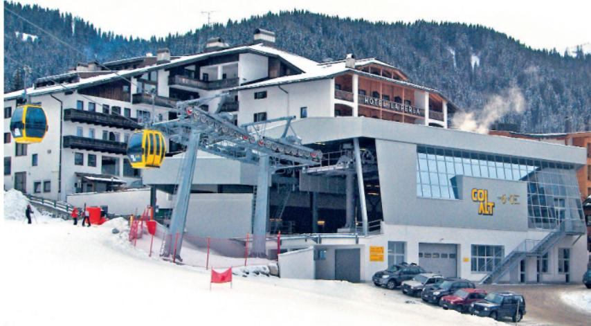
*La stazione a valle del Col Alt. La cabinovia ad ammorsamento automatico con cabine ad 8 posti è stata inaugurata nel 2006. Essa ha una lunghezza di 1017 m. e supera con nove piloni un dislivello di 420,74 m.. Grazie a una velocità di 5,14 m/s l'impianto raggiunge in inverno una portata oraria massima di 2.400 persone.*
