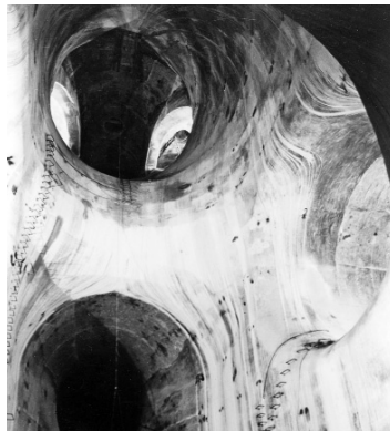
Pozzo piezometrico senza acqua; confluenza delle derivazioni di Isarco e Rienza
