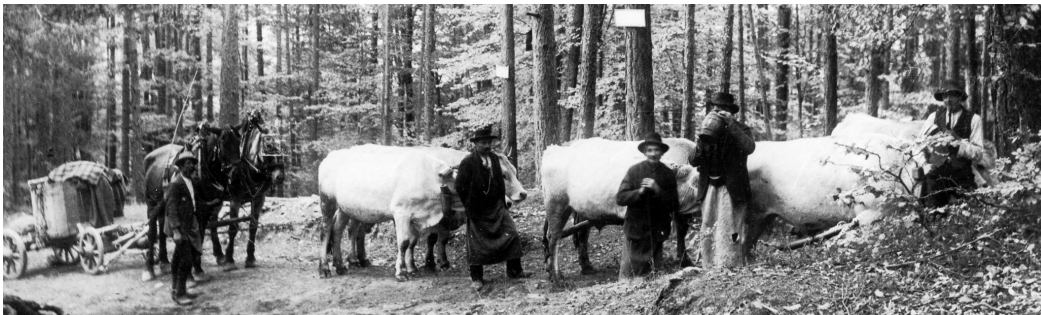
Lavori di costruzione della funivia del Colle
