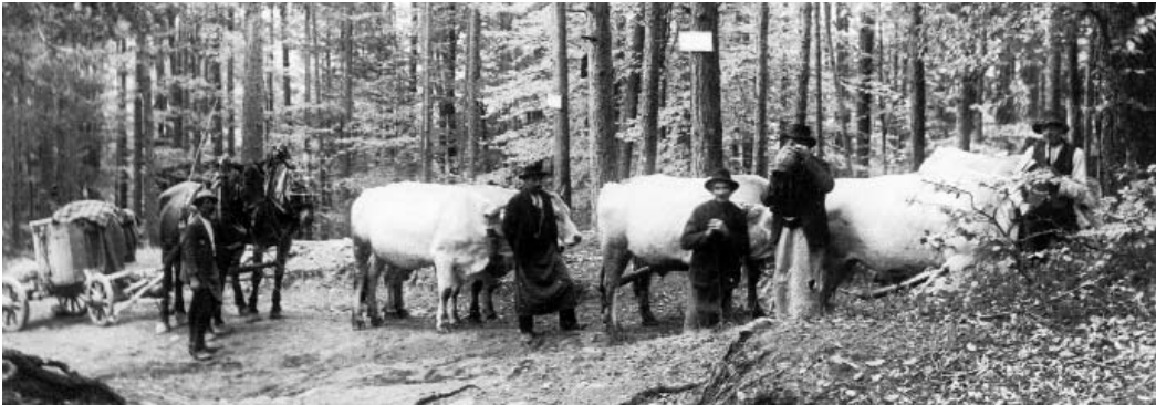
Bauarbeiten für die Kohlererbahn.
